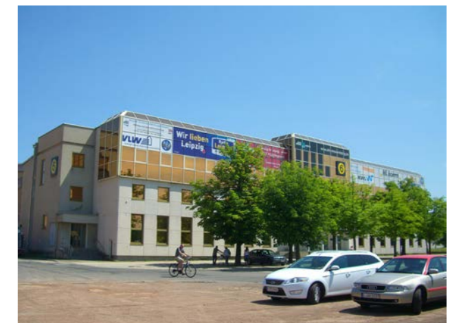
Blick von der Straße des 18. Oktober auf die Messehalle 6. Fotos: Dave Tarassow
