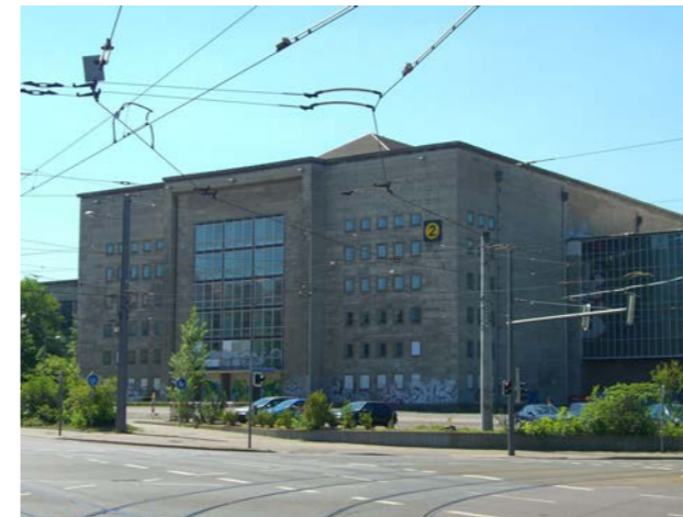
Der Portikus der Messehalle 2 bildet den Nordkopf der Technischen Messe.
