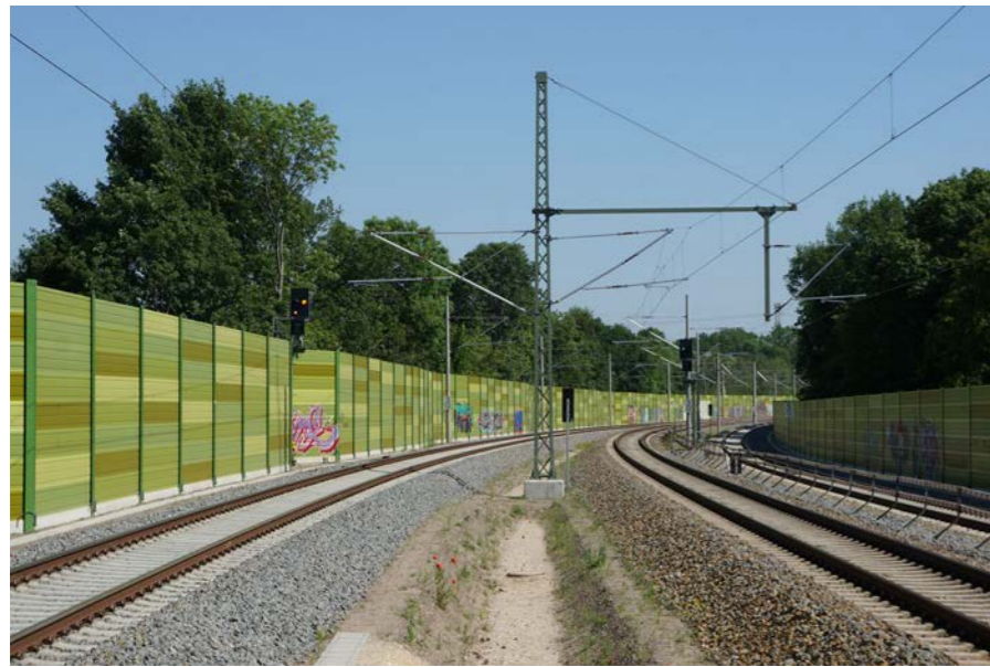
Blick vom Haltepunkt Markkleeberg Nord auf die beidseitigen Lärmschutzwände in Richtung Leipzig. Diese erstrecken sich zwischen dem Bf. Leipzig-Connewitz und Markkleeberg-Großstädteln.
