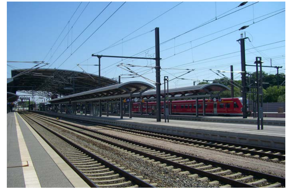
Der neue Erfurter Hauptbahnhof mit durchgehenden Gleisen und Sackgleisen. Fotos: Dave Tarassow
