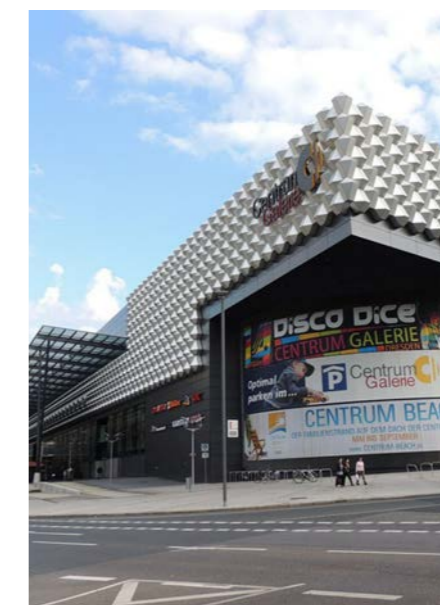
Die Centrum-Galerie wird zurzeit umgebaut. Foto: Reinhard Jentsch / dresdner-bauten.com
