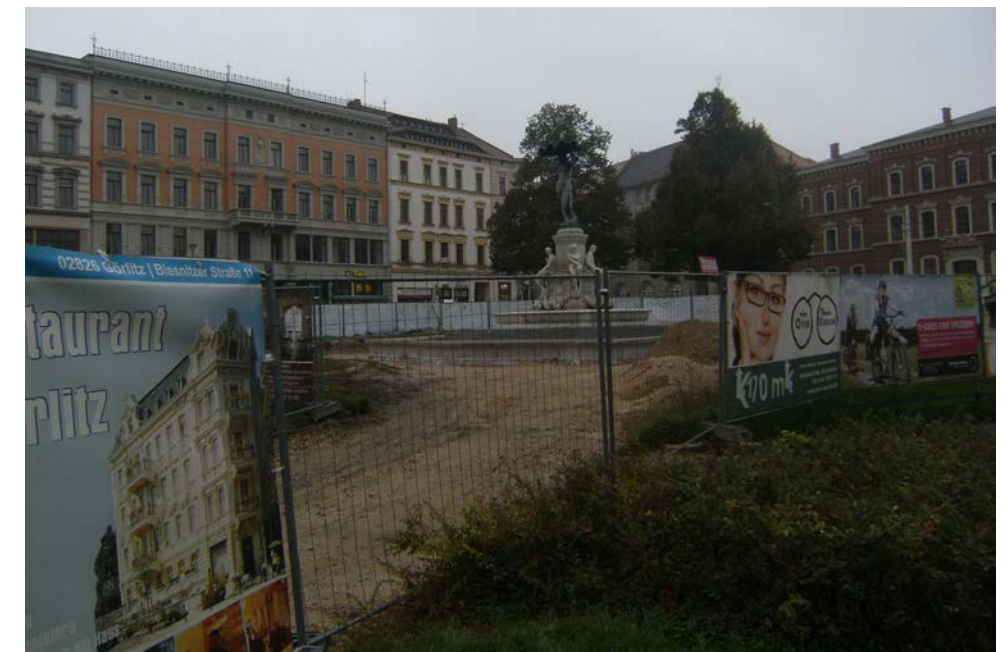
Blick auf den Postplatz, der mittlerweile zur Baustelle wurde.
