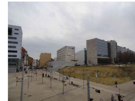
Blick in die Hinterhöfe der Stadt nach Abriss „Wohnturm Nord“. Fotos: Reiner Halle
