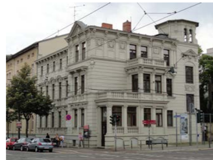
Sanierte Stadtvilla am Mühlweg.
