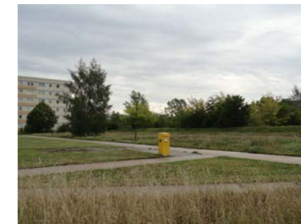
Unvollständiger statt komplettem Abriss und Bereitstellung für Eigenheimsiedlungen.
