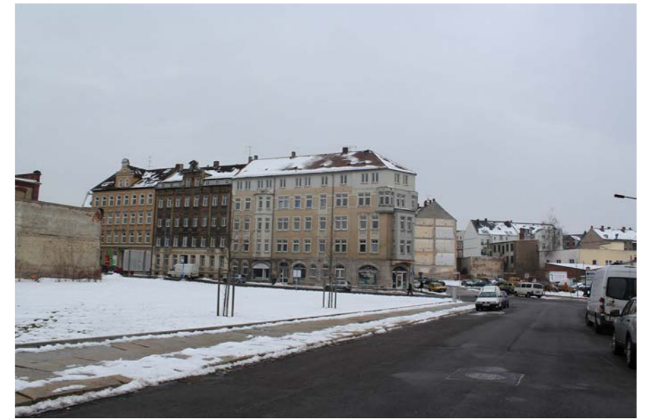
Eine große Brachfläche an der Reinhardtstraße Ecke Palmstraße nach dem Abriss.
