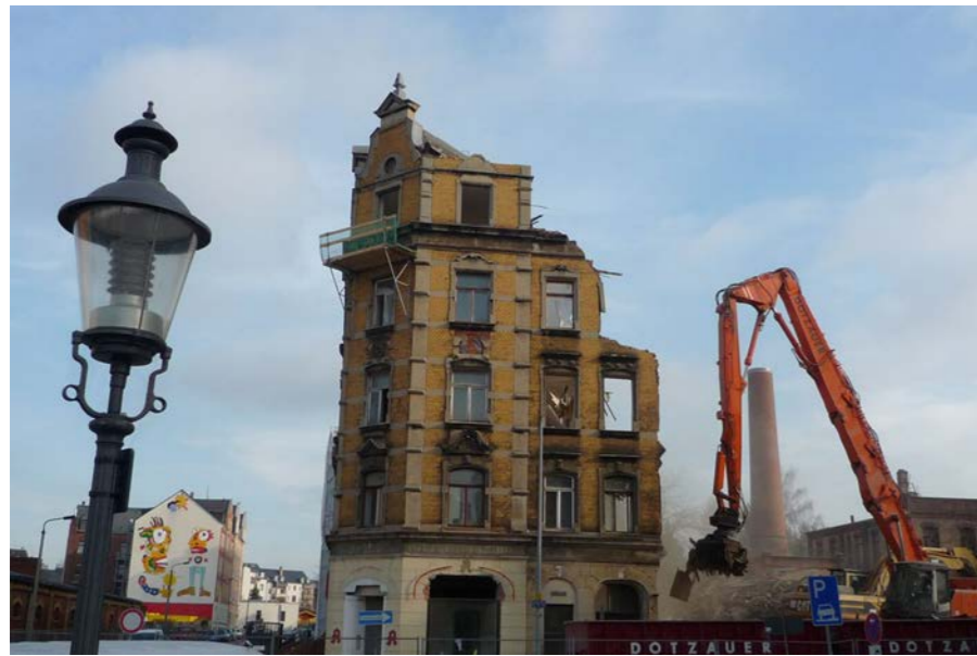
Stadtumbau Ost in Chemnitz: Das Bild zeigt den Abriss eines Eckhauses an der Reinhardtstraße Ecke Palmstraße. An dieser Kreuzung stehen noch zwei weitere Eckhäuser. Fotos: Stadtforum Chemnitz
