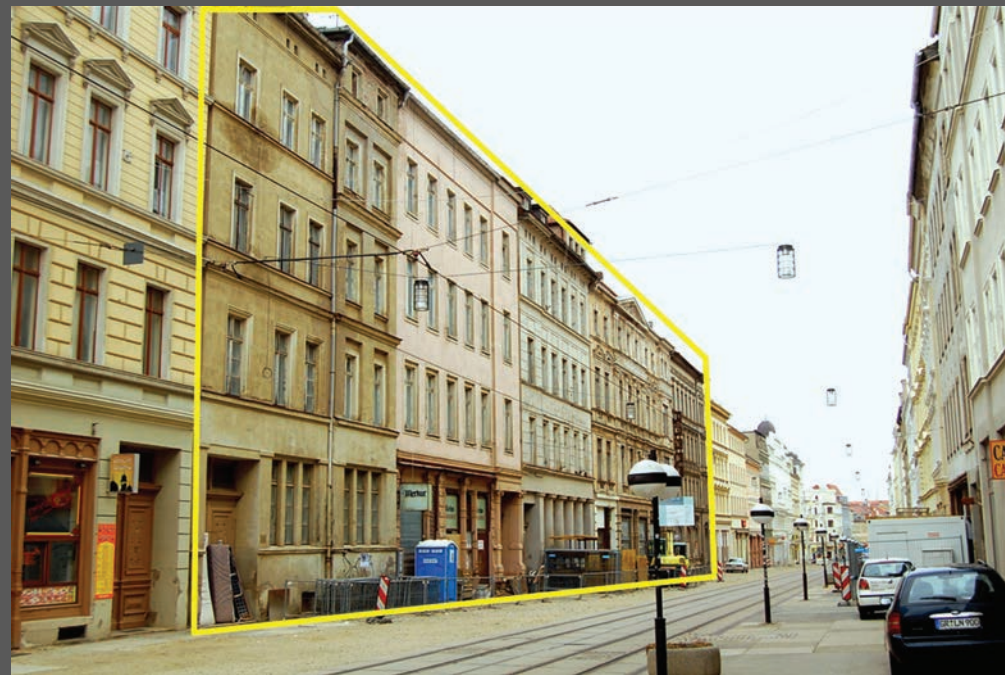
Berliner Straße, Blick stadteinwärts, Gelb: Abbruchbereich.
